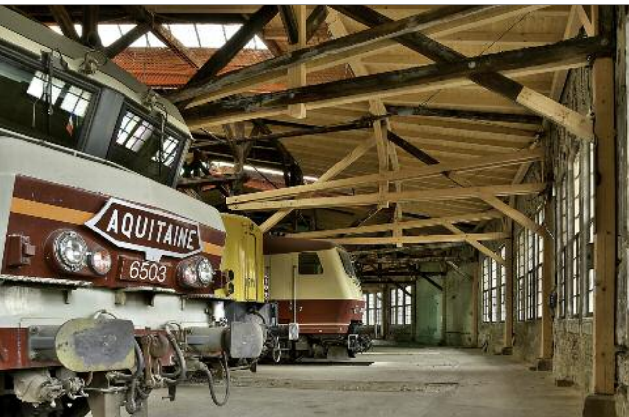
Nach Abschluss des ersten Bauabschnittes kann sich das Ergebnis durchaus sehen lassen: Blick in das sanierte Rundhaus mit den „Botschafter-Lokomotiven“ CC 6503 aus Frankreich und 1211 aus den Niederlanden. Im Hintergrund steht die deutsche 120 003.
