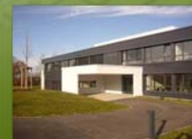
Sanierung Schule, Ottobeuren
